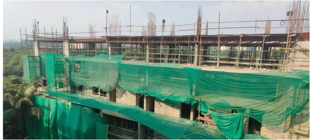
Hostel H -08 –9th Floor Pour A slab Shuttering Work
