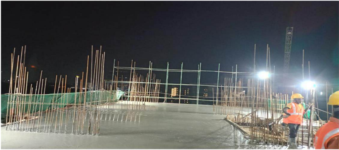
Hostel H-21- 9 th Floor Pour B Slab Casting Completed
